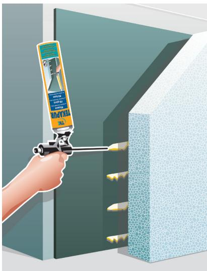
Пена для приклеивания изоляционных плит – однокомпонентная полиуретановая пена, имеющая незначительное вторичное расширение, предназначена для крепления изоляционных материалов с помощью монтажного пистолета.
